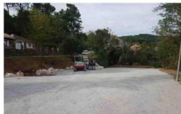
Ainsi, sa rénovation (aplanissement du sol, enrochement, pose de gravier concassé et plantations) permet à présent de garer une quarantaine de véhicules.
